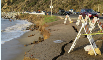
Los Angeles (erosion, 2016)
